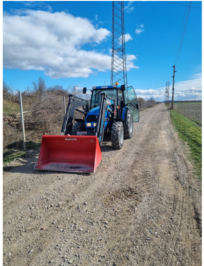
Foto: zeigt die Sanierung des Zufahrtsweges
